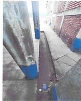
Foto 2: Reparación de cuneta de recaudación de agua pluvial
